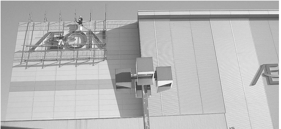
2011年3月3日撮影。ショッピングセンターの看板の付け替え時の作業の様子。人間の大きさと比較してみよう。
