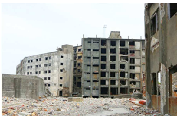
写真3:今の30号棟・31号棟アパート
