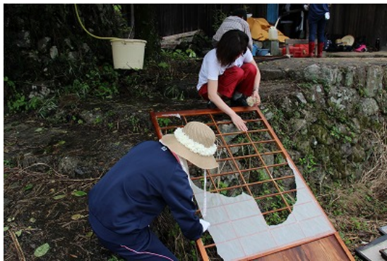
写真4 障子の張り替え
