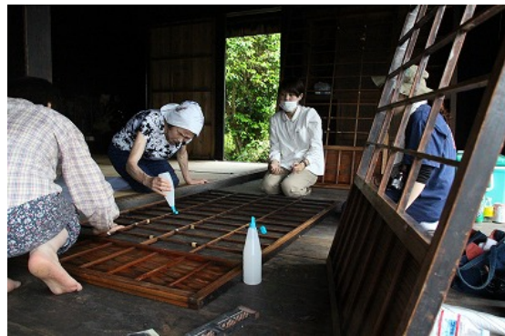
写真5 障子の張り替え
