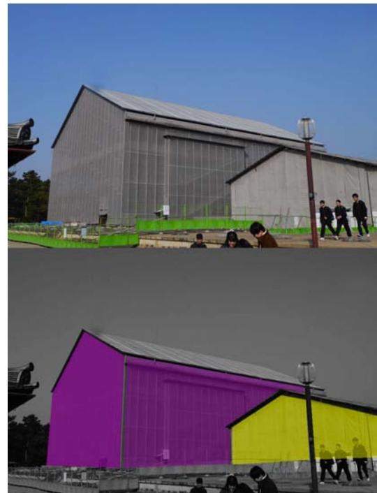
図 4 アートインフラ：再現工事の仮囲い
