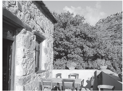
写真4 レストラン、レセプション棟にあるバルコニー。昔ながらの伝統的 石造建築を踏襲し、再生した
